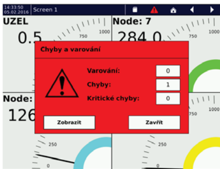
Chybové okno stavu „Chyba“
